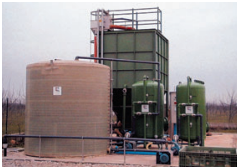
Batteria filtri a sabbia e a carbone attivo
