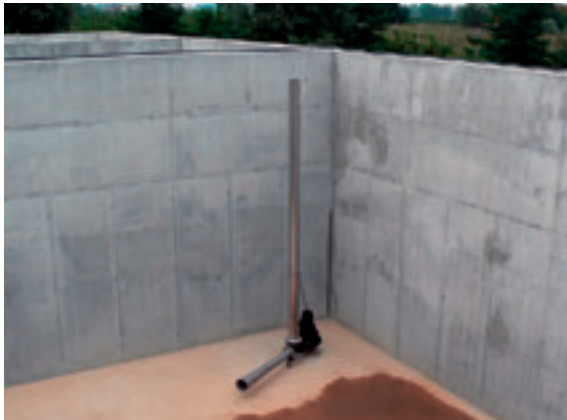
Sistemi di aerazione vasca accumulo e ossidazione
