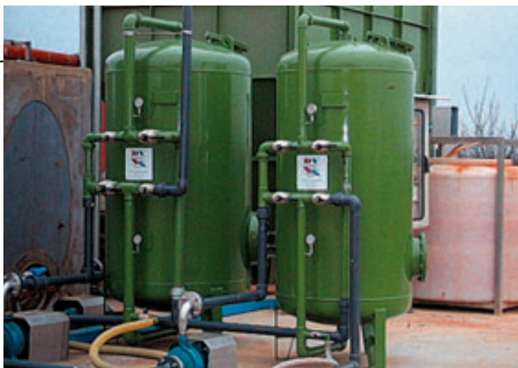
Batteria filtri a sabbia e a carbone attivo
