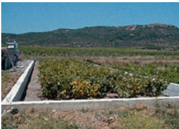
Vasca di fitodepurazione con flusso sub-orizzontale
